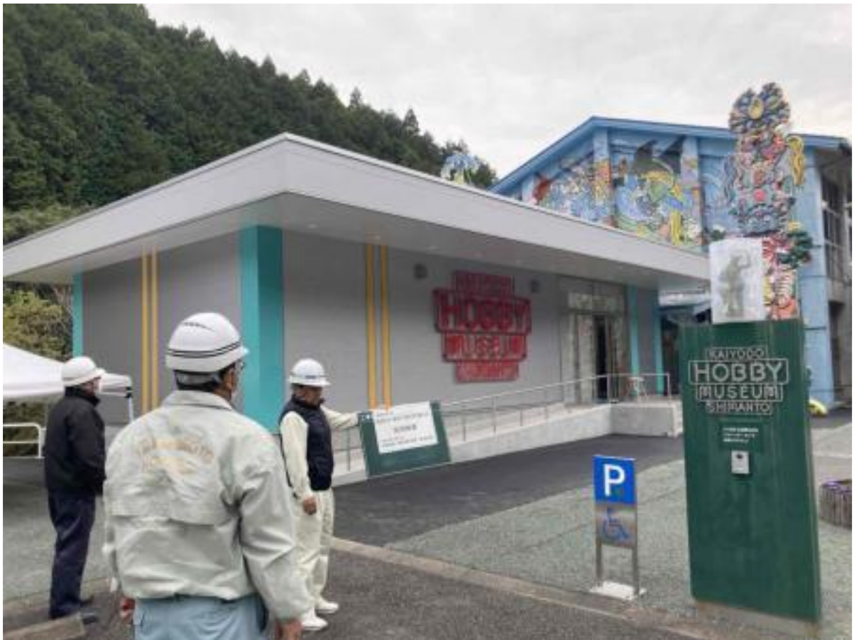
ホビー館改修写真（1階増築部分）
